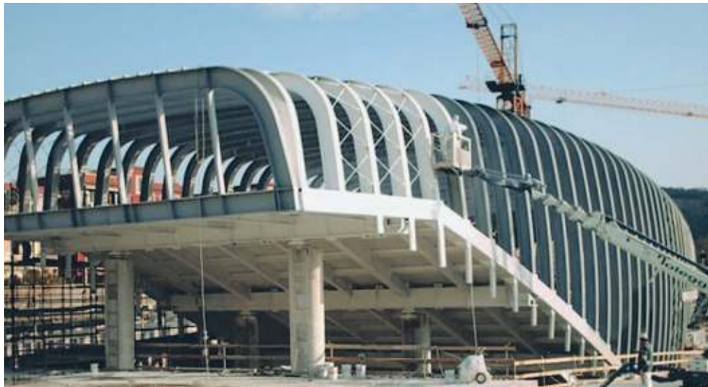
IL TEAM PROGETTA PIANI EDILI E SI OCCUPA DELLA DIREZIONE DEI LAVORI E DELLA SICUREZZA IN CANTIERE
